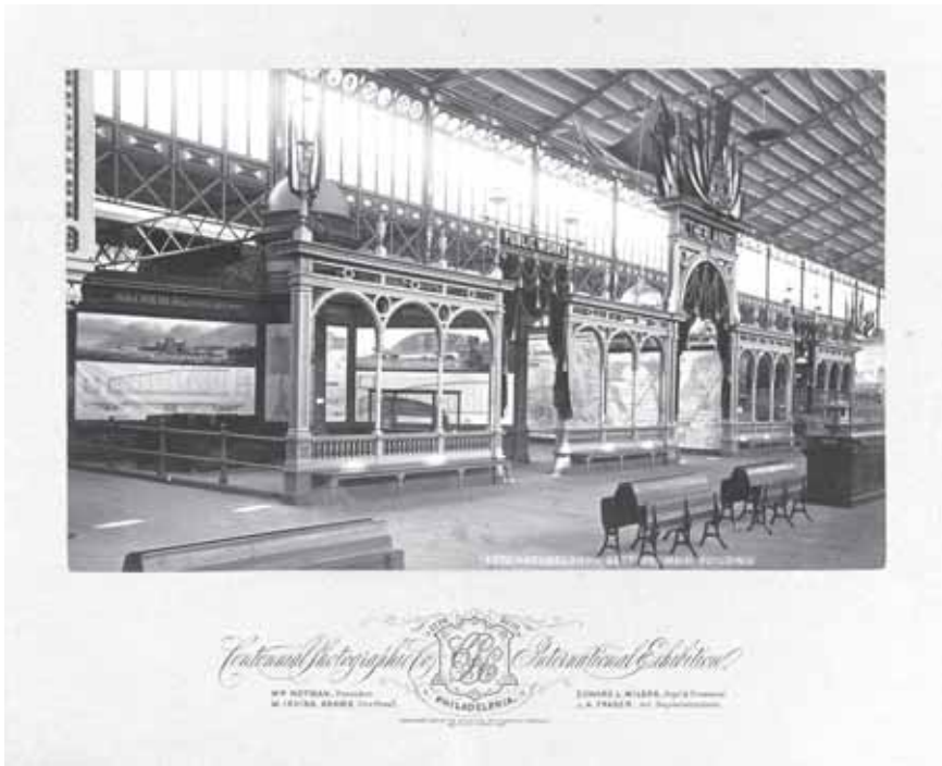
Afb. 3 Voorgevel van de Nederlandse afdeling in het Main Building; achter de ingangspoorten is de inzending 'Publieke Werken' te zien. Foto Collectie Rijksmuseum.
